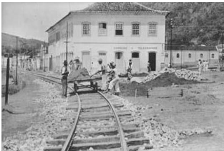
Figura 58: Construção da linha férrea com o primeiro aterro da cidade. Data e autoria desconhecidos. Fonte: Iphan.
